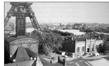
Fördermaschinenanlage Schacht IV mit Doppelstrebengerüst
