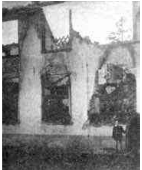
Zerstörtes städtisches Verwaltungsgebäude am Schlosspark
