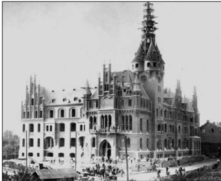
Rathaus Gelsenkirchen im Bau, 1894
