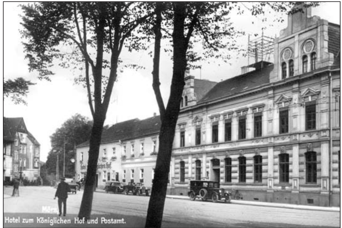
Kaiserliches Postamt, Uerdinger Straße, erbaut 1882
